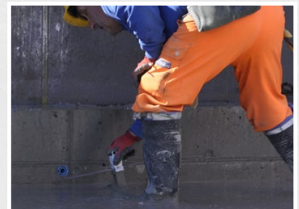
Beide Absperrhülsen lassen sich auch problemlos in den frischen Beton versetzen
