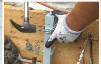
Die Absperrhülse zum Aufnageln lässt sich vorzugsweise mit Aluminiumnägeln einfach befestigen
