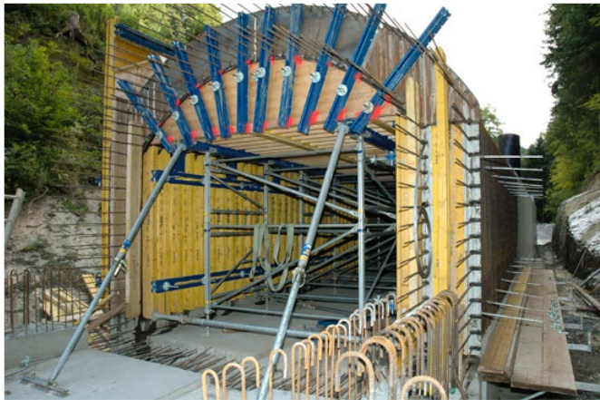
Top-Form im Tunnelbau
