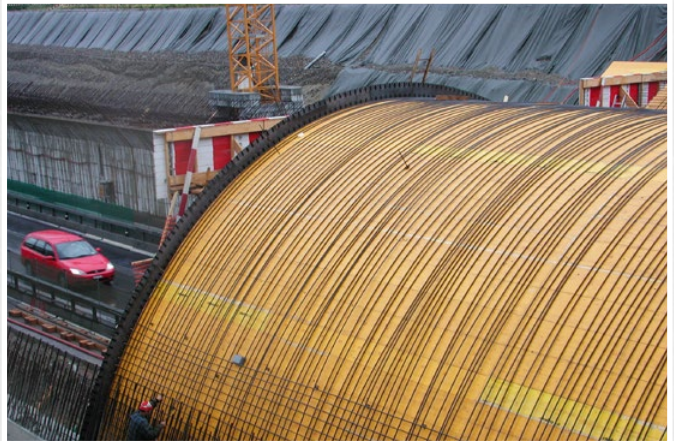
Top-Form im Tunnelbau
