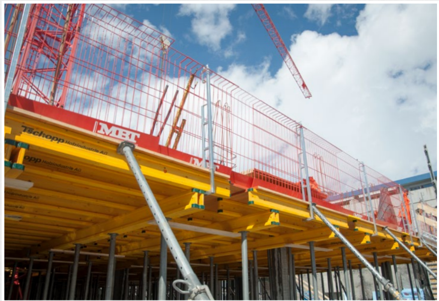
Safe-Gard mit Kurbelpfosten an Deckentisch montiert
