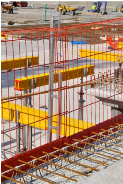
Safe-Gard mit Kurbelpfosten an Elementdecke montiert
