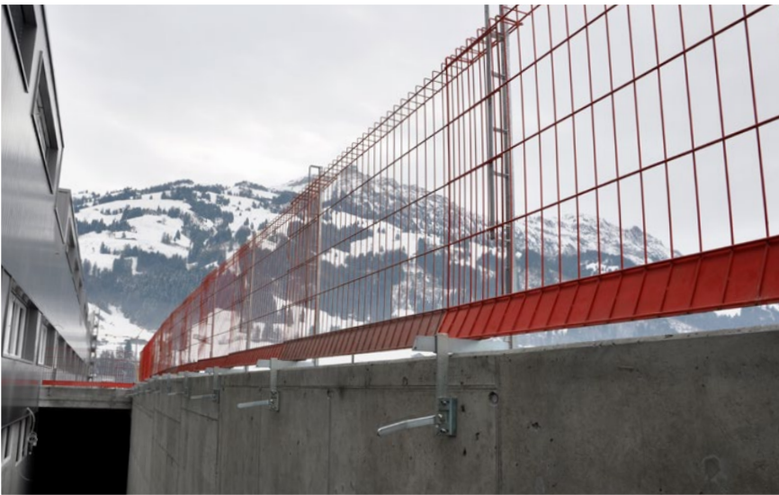
Safe-Gard mit Kombifix-Klemme als Seitenschutz montiert
