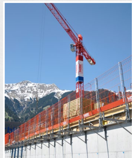
Safe-Gard Seitenschutz in Kombination mit dem BKA Pro System
