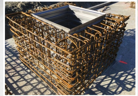
TBA-Aussparung im Einsatz
