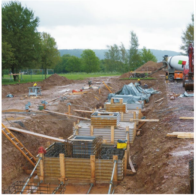
TBA Aussparung als Innen- und Aussenschalung
