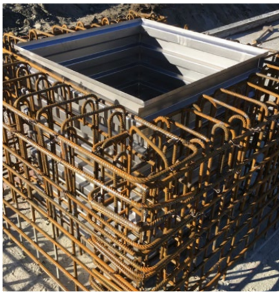
TBA Aussparung im Einsatz
