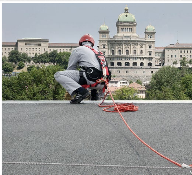
Gesichert an der Lifeline Stahl mit einem KiBo Seilkürzer
