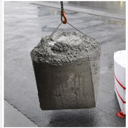
Der Betonwürfel kann nun einfach und sicher entsorgt und die Restbeton-Box erneut verwendet werden.
