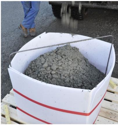
Die Restbeton-Box kann (auch in mehreren Etappen) bis zum Rand mit Restbeton gefüllt werden.
