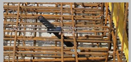
Nach dem Betonieren kann der Zapfen entfernt und die DW 15 mm Verankerung verwendet werden.
