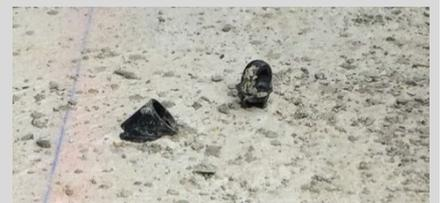
Der PE-45° Anker kann bündig zum Betonboden abgeschlagen werden.
