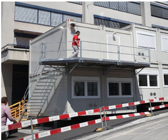
Air-Step Zugang über Modul «Ecke für Treppenzugang»
