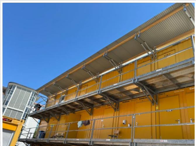
Schneesichere Vordächer mit Air-Step Modul Dach
