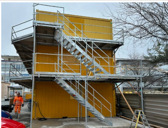
Air-Step Modul Treppenhaus 1. OG und DG
