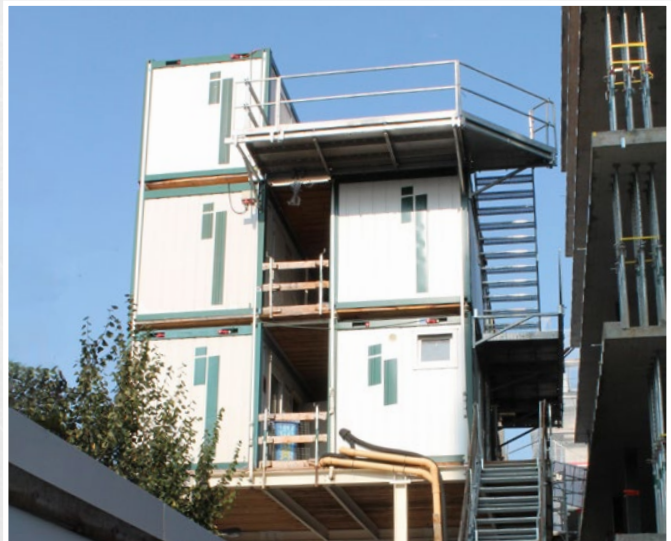
Air-Step Zugänge zu mehreren Containern
