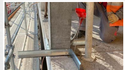
Aufwendiges Abschalen und Schäumen entfällt
