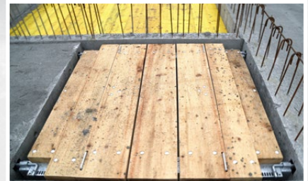
Die Lift-Plattform ermöglicht das rationale Sichern von Liftschachtöffnungen
