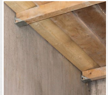
Gerüstschuh montiert
