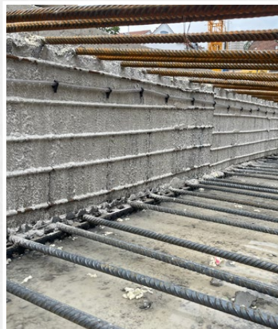
Injektionsschläuche und Injektionskanäle können mittig befestigt werden
