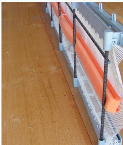
Bezüglich Wasserabdichtung kann mit dem entsprechenden Abdichtungsunternehmen eine Lösung erarbeitet werden
