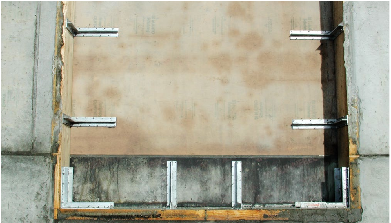
Der Leibungsschalungswinkel eignet sich für Aussparungen jeglicher Art
