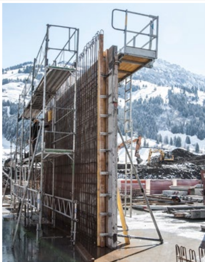
Leibungsschalungswinkel sind optimal für den Einsatz bei Wandschalungen
