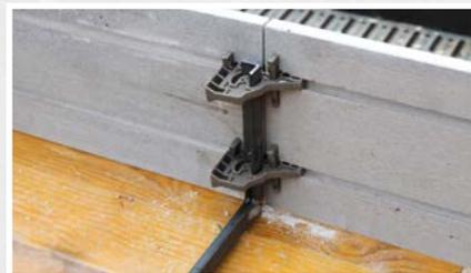
Die Abschalwinkel sind mit den Läufern stufenlos in der Nut der Platte verschiebbar. Die Elemente können so optimal in der Längsrichtung kraftschlüssig verbunden werden
