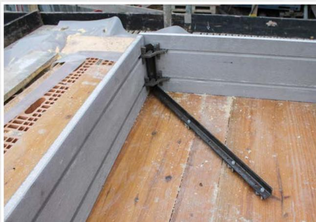
Die Bordfix Abschalwinkel können von eingeklappt bis auf 90° stufenlos gerichtet werden
