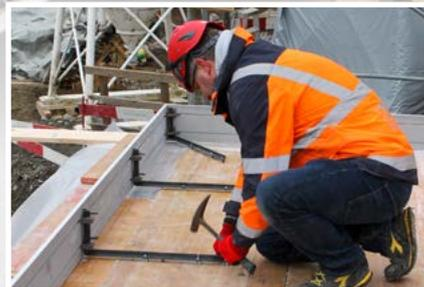
Zum Fixieren des 2.8 m langen Bordfix Elements werden die Abschalwinkel ausgeklappt und mit Aluminium-Nägeln befestigt
