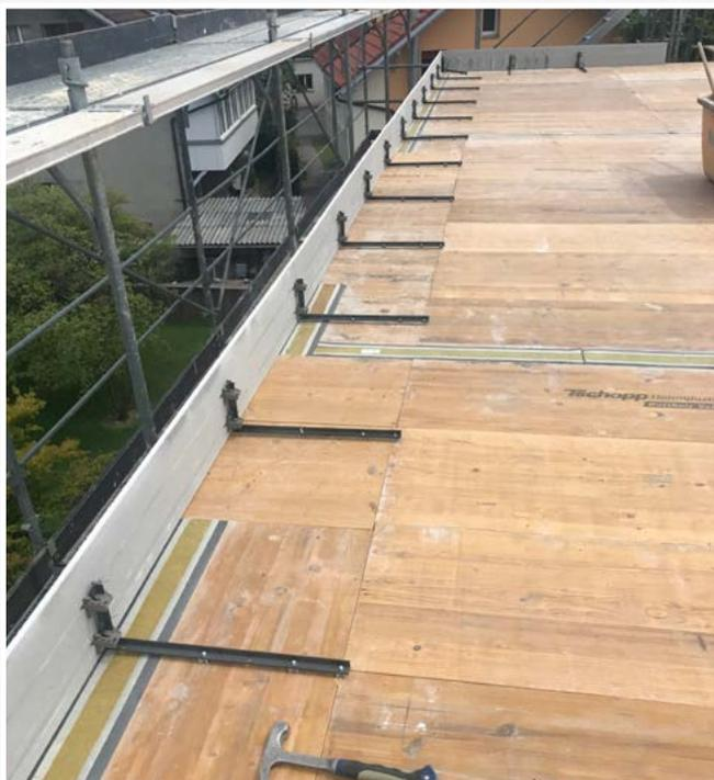
Zum Fixieren des 2.8 m langen Bordfix Elements werden die Abschalwinkel ausgeklappt, das Element an den Deckenrand geschoben und mit Aluminium-Nägeln fixiert
