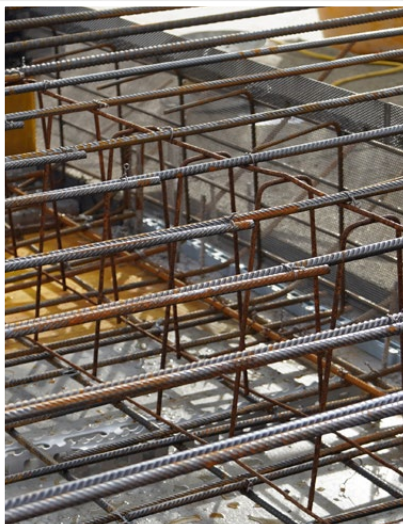
Die obere Armierung kann sauber auf das AES aufgelegt werden
