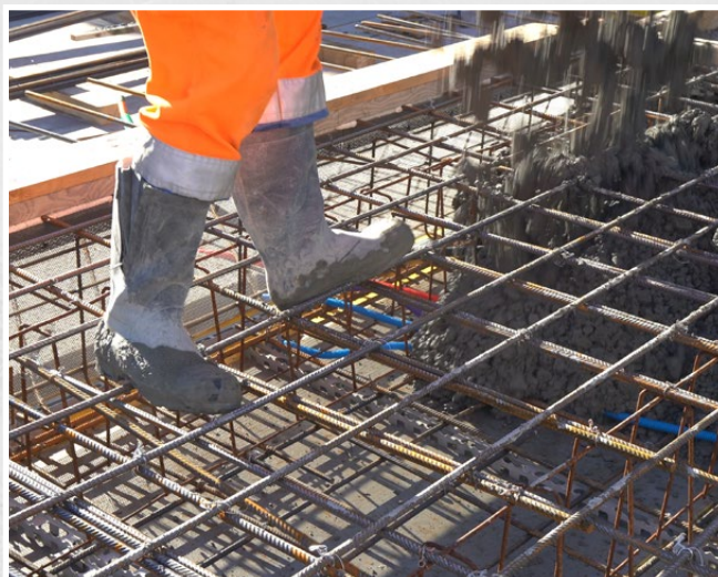
AES beim Betoniervorgang
