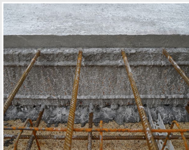
AES nach dem Betonieren und Entfernen des Kantholzes
