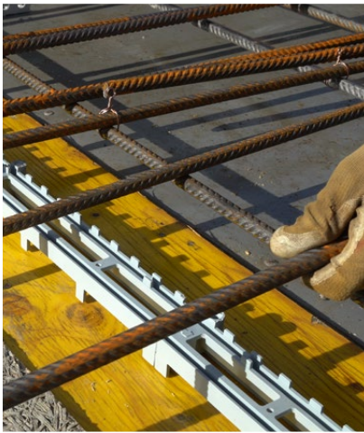
Auflegen der ersten und zweiten Armierung auf eine Distanzschiene, z.B. Net-Form Schiene Art. 1771 oder Abschalkamm Art. 1920
