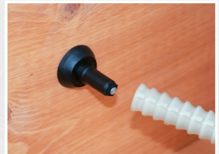
FiberTec Ankerhülse 15 mm beim Versetzen
