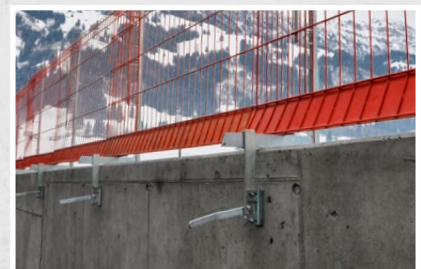
Kombifix-Klemme mit Safe-Gard Seitenschutz als Absturzsicherung
