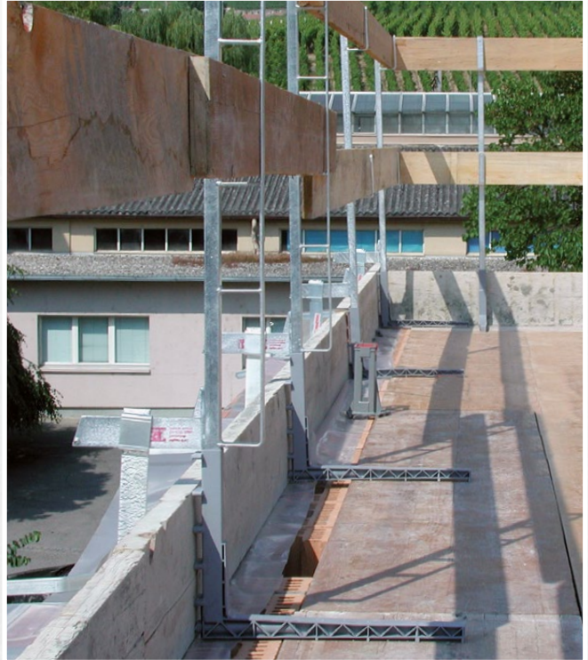
Deckenrandabschalung und Kombifix-Klemme mit Brustwehr
