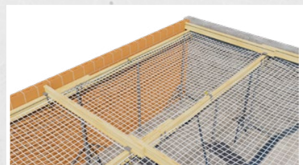
Schon ist Spider-Net montiert und das Schalen von oben kann beginnen
