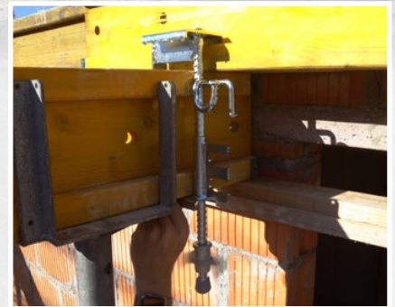
Verschwenkhalter mit Joch- und Querträger verspannen
