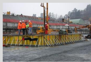
Top-Form S1 im Einsatz mit Abschalstütze AST SK
