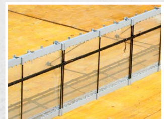
Net-Form befestigt mit Aluminium-Nägeln 3.1 x 65 mm
