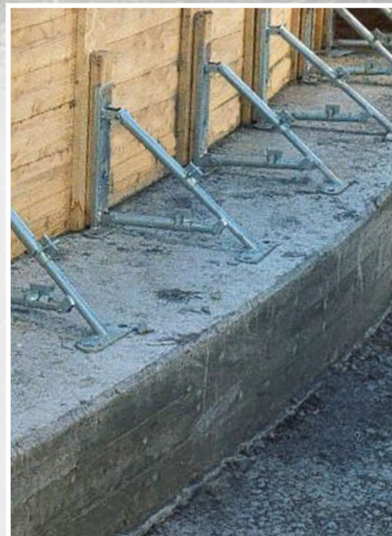
BPA auf Beton aufgeschraubt
