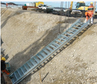
Die Grabentreppe bei der Montage
