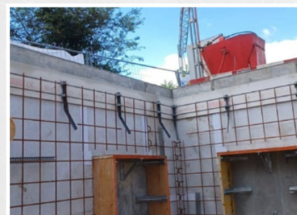
In der Länge und den Ecken lassen sich die Elemente kraftschlüssig verbinden
