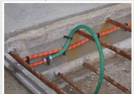
Roll-Net kann auch in Kombination mit Injektionsschläuchen verwendet werden
