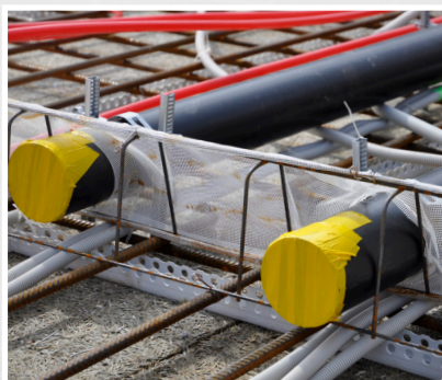
Zum Durchführen von diversen Installationen (z.B. Rohre), einfach Kreuz einschneiden, Installation hindurchführen und Netzlappen an der Installation mit Betonklebeband ankleben
