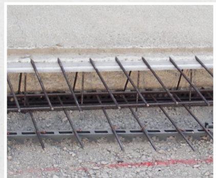
Roll-Net nach dem Betoniervorgang
