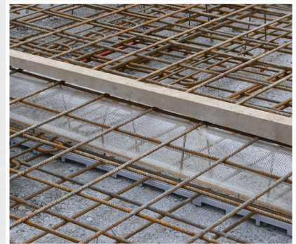
Verlegen der oberen Armierung und fixieren eines Abschlussbrettes
