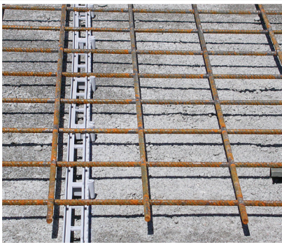
Verlegen z.B. der Net-Form Schienen und Armierung
