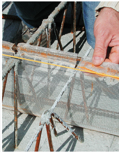
Bei höher liegender oberen Armierungslage kann das Roll-Net eingeschnitten, hochgezogen und mit dem Einschieben des Eisens fixiert werden.
