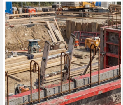
Einhängen der Leiterhalterung an der Wandschalung...
