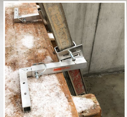
Aufnageln oder aufschrauben der Leiterhalterung auf der Deckenschalung oder der Betondecke
