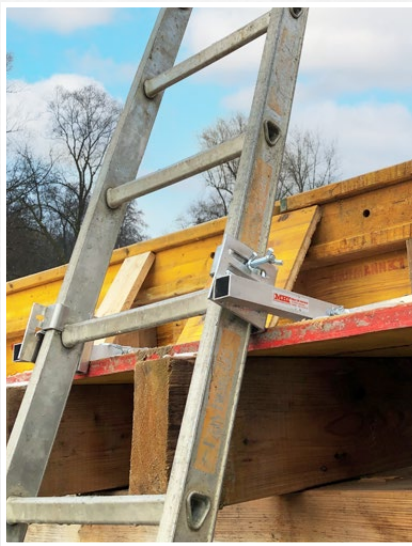
Sicheres Befestigen der Leiter in einem optimalen 75° Winkel
