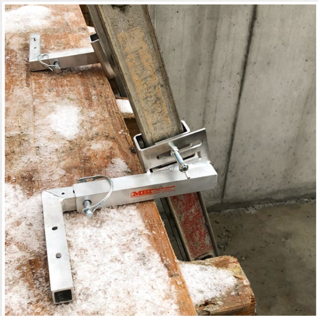
Einstellbare Befestigungsrohre, welche horizontal oder vertikal ausgerichtet und mit Rohrklappsplinten gesichert werden
