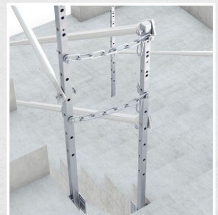
Übergang gesichert mit Geländerketten
