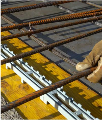
Auflegen der ersten und zweiten Armierung auf eine Distanzschiene, z.B. Net-Form Schiene Art. 1771
