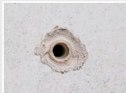
FiberTec Klebanker versetzt
