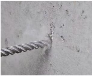
Bohrloch  $\varnothing$  30 bzw. 36 mm
