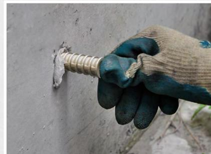
FiberTec Klebanker einkleben
