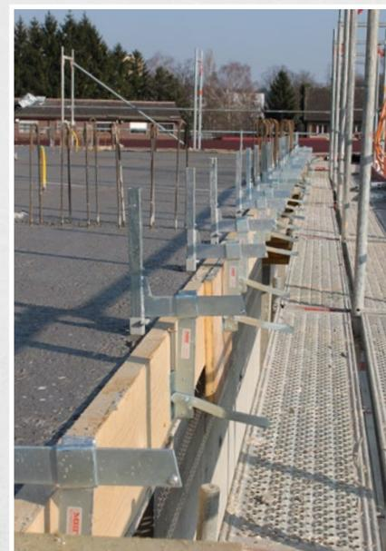
Kombifix-Winkel in Verwendung mit der Kombifix-Klemme nach dem Betoniervorgang
