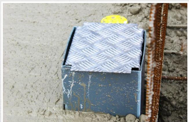
Der Stolperschutz kann vor oder nach dem Betonieren montiert werden
