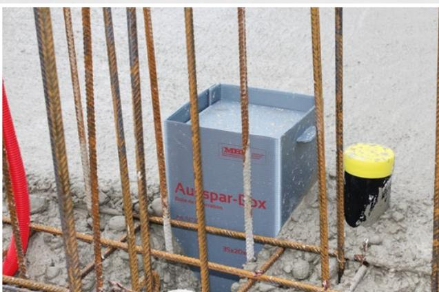
Die Ausspar-Box hält den Belastungen beim Betonieren stand
