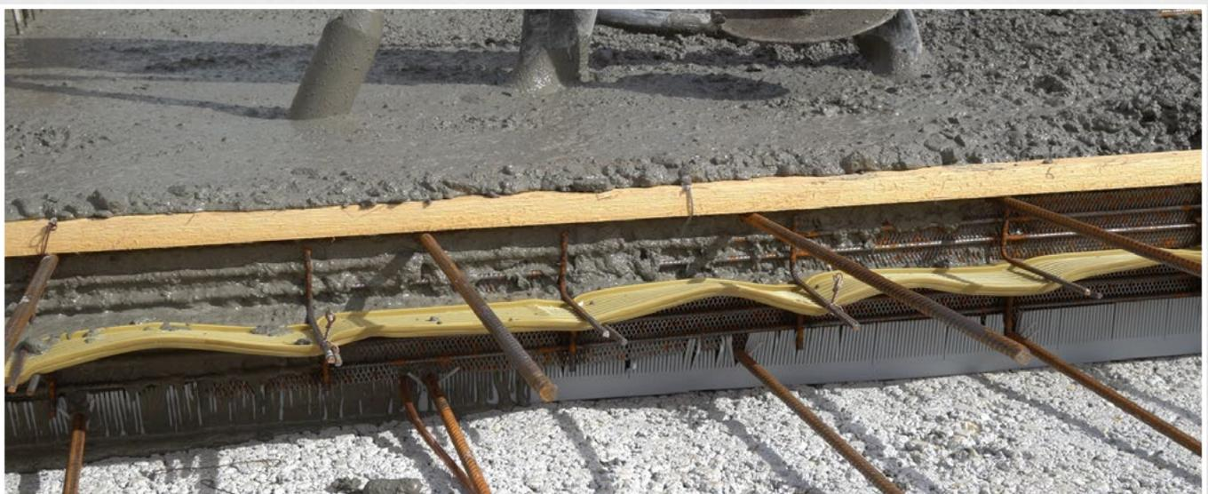
Le peigne de coffrage ferme les espaces de façon à empêcher que le béton s'échappe.
