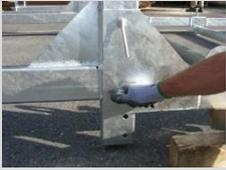
Einfügen und Verschrauben des frontseitigen Querholmen und den Wangen mit Hebelschrauben und Hebelmutter M16 x 90 mm.
