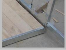
Verschrauben der Zugbänder mit den dazu gelieferten Hebelschrauben und Hebelmutter M20 x 40 mm.
