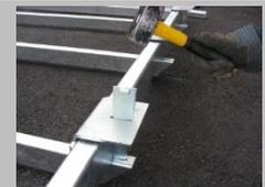
Zusammenfügen der Tragholme mit den Wangen und anschliessendes Verschrauben mit den dazu gelieferten Hebelschrauben und Hebelmutter M20 x 90 mm.
