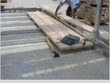
Schliessen des Gerüstbelags mit dem Abschluss-Querholmen. Abschluss-Querholmen und Tragholme mit Hebelschrauben und Hebelmutter M16 x 90 mm verschrauben.
