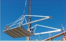
Einführen der MS-Plattform Extrem 4000 durch eine mit PSAG gesicherte Person.
