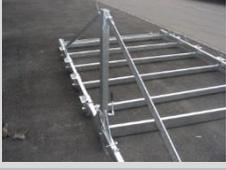
Einstecken der Seitenschutzgeländer und des Front-Seitenschutzes.
