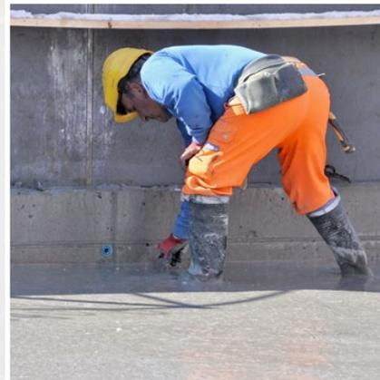
Versetzen von UNO-Ankerfix im frischen Beton
