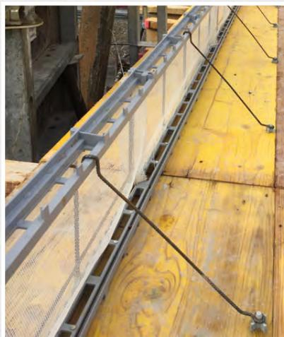
Die optionalen Zuglaschen ermöglichen ein einfaches Ausrichten und Montieren des Net-Forms
