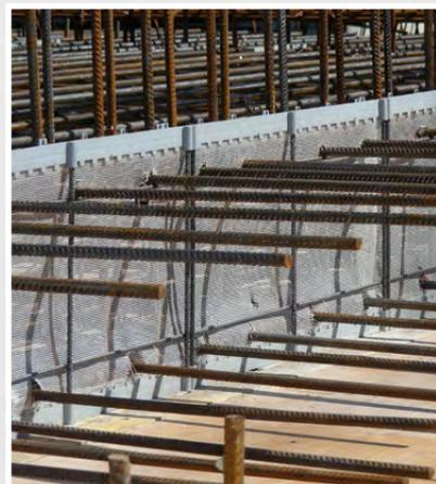
...und oben durch das Glasfasernetz hindurchgestossen werden.
