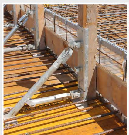
Bei hohen Betoneinfüllgeschwindigkeiten empfehlen wir ab einer Deckenstärke von 36 cm eine Aussteifung z.B. mit unserem BPA
