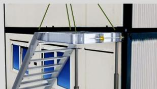
Stützfüsse an Terrain anpassen und mit Schrauben anziehen. Es ist darauf zu achten, dass das Podest Waagrecht ausgerichtet ist.
