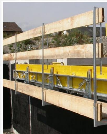
*Steckpfosten in Kombination mit der BKA Pro Konsole*
