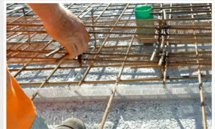
Beim Auflegen der Armierungseisen wird der Kamm im betroffenen Bereich umgeknickt...
