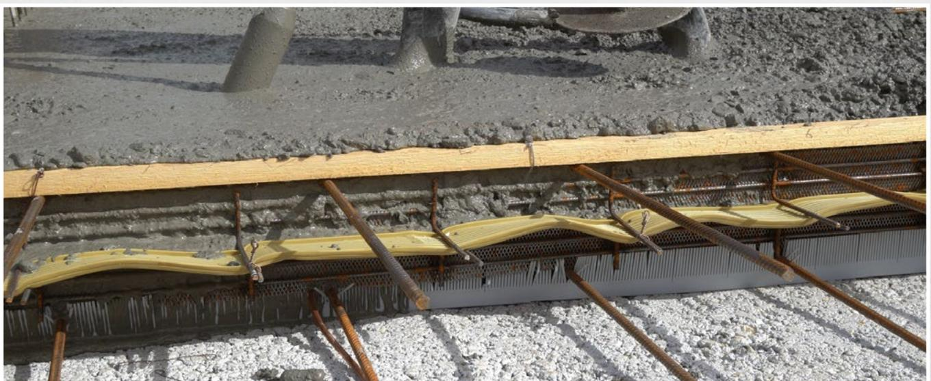
Der Abschalkamm schliesst die Zwischenräume optimal, damit wenig Beton austritt
