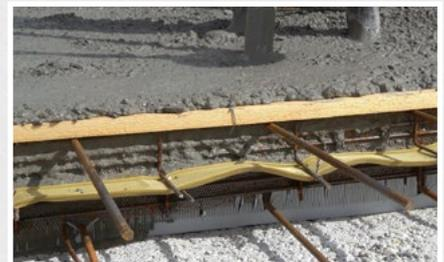
...wobei der restliche Kamm stehen bleibt und die Zwischenräume zwischen den Armierungseisen optimal schliesst
