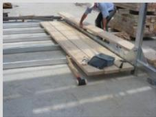
Schliessen des Gerüstbelags mit dem Abschluss-Querholmen, Abschluss-Querholmen und Tragholmen mit Hebelschrauben und Hebelmuttern M16 x 90 mm verschrauben.
