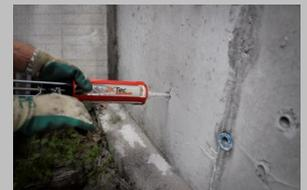
Den FiberTec Klebanker mit Drehbewegungen in die Klebmasse einführen und den Injektionsmörtel aushärten lassen (Aushärtezeit gemäss Beschreibung auf der Kartusche).
