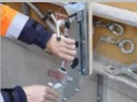
Querkeil des Schlittens mit einem Hammer festziehen.
