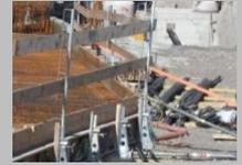
Es ist darauf zu achten, dass der Sicherungsbolzen des Steckpfostens im Sicherungsloch des BKA Pro Schlittens einrastet und somit der Steckpfosten gegen unbeabsichtigtes Herausheben gesichert ist.
