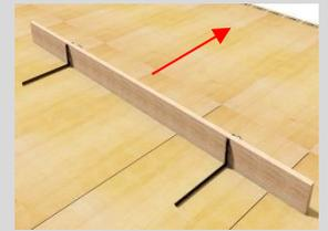
Die Randfix-Winkel auf der Deckenschalung ausrichten und mit je drei Alu-Nägeln Ø3.1 x45 mm aufnageln.
