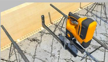
Nageldübel Ø6x35 durch die Löcher des Randfix-Winkel in die Löcher der Elementdecken hineindrücken und einschlagen.
