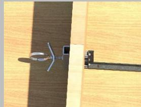
Der Randfix-Winkel und das Schalbrett sind im montierten Zustand an den Deckenrand zu stellen.
