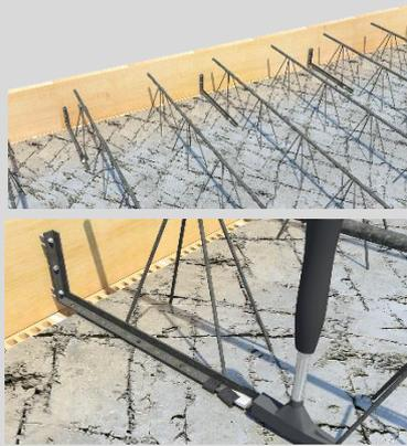
Abschalbrett mit Spanneisen an Randfix-Winkel für Elementdecken Art.1106 befestigt und mit Nageldübel auf Elementdecke fixiert
