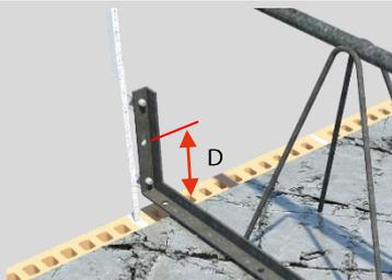
Winkelabstand der Löcher sind gemäss Tabelle auf Seite 4 unter Punkt «Technische Daten» anzuordnen und Mass E sind mit Bohrloch Ø12 mm in das Schalbrett zu bohren.
